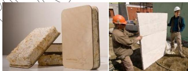
*Panneaux isolants à base de mycelium, Ecovative Design*
